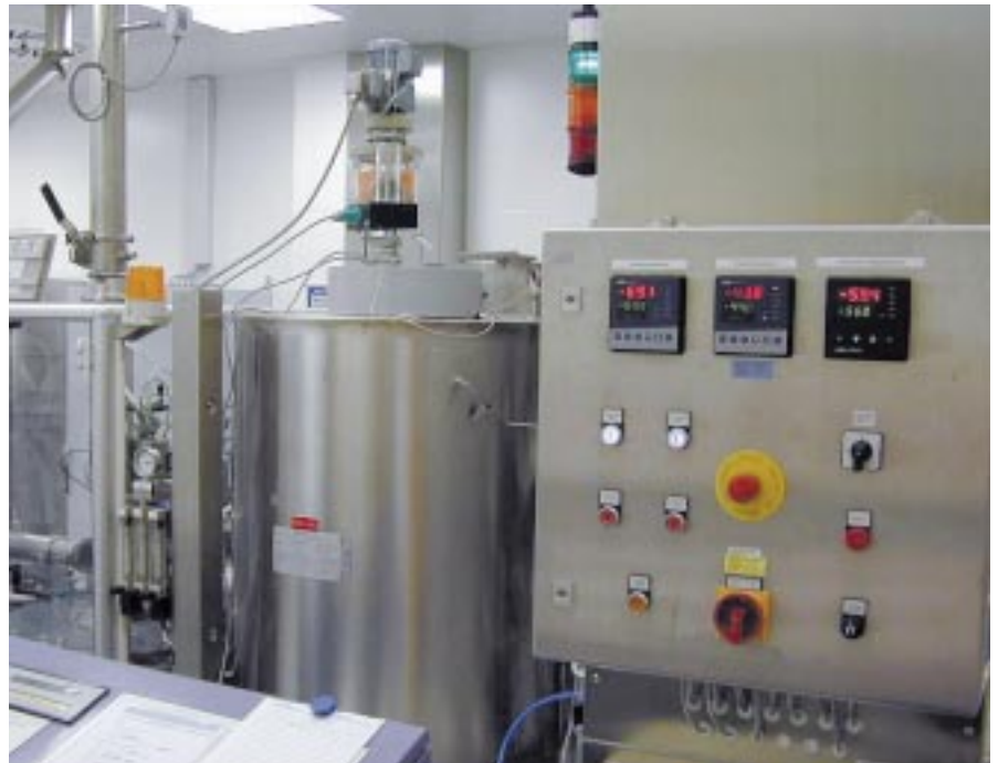
Abb. 4: Die neuen Produktkühler lassen sich auf Grund der kompakten Ausführung perfekt in die vorhandene Infrastruktur integrieren
