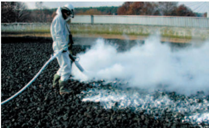
Die Oberfläche von Tropfkörper-Füllungen wird sukzessive mit Kohlendioxid-Schnee abgedeckt.
