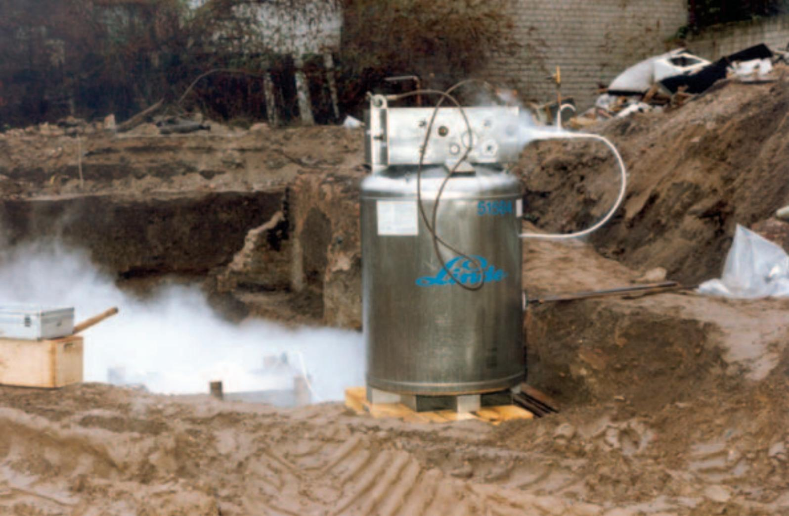
Mobile Baustellenversorgung mit flüssigem Stickstoff im Kryobehälter
