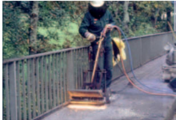
Entfernung einer alten Asphaltdecke durch Flammsschalen
