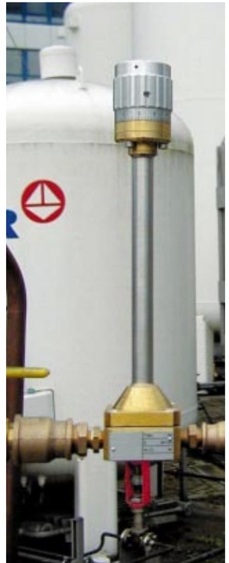
Abb. 7: Laminar-Drosselventil vom Typ LDV 4,9 (95.70.140.b)
